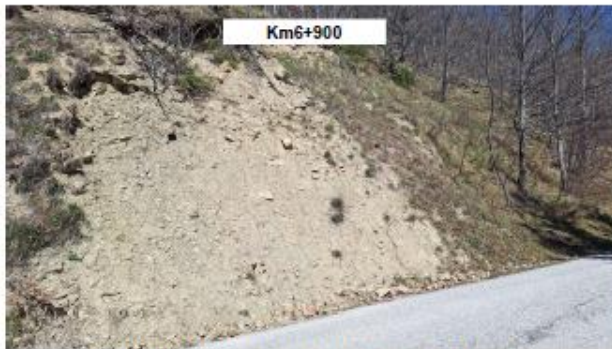
Caduta massi e materiale fine dalla scarpata stradale di monte
