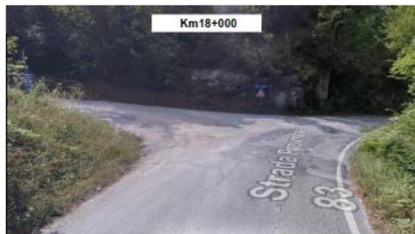
Dissesti del manto e regimazione acque delle acque non funzionale
