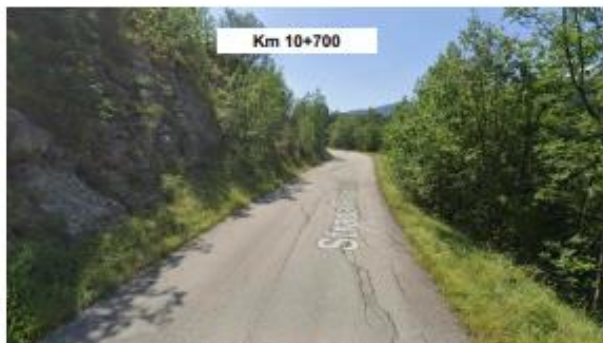
Dissesti del manto e cedimento scarpata di valle
