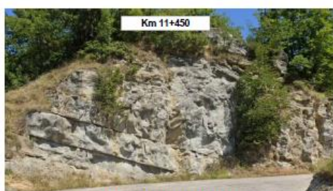
Rilascio di materiale lapideo dalla scarpata di monte
