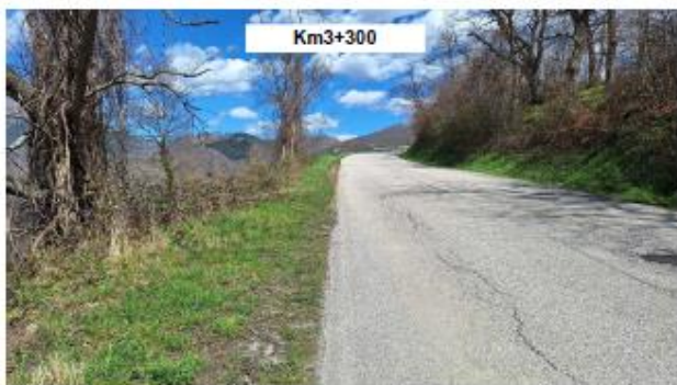
Dissesti del manto e cedimento della scarpata di valle
