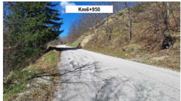
Dissesti del manto e cedimento della scarpata di valle
